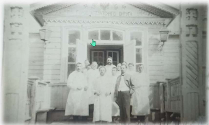
Врачи у входа в Главный госпиталь
